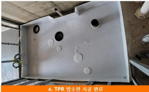
4. TPR 방수판 시공 완료
